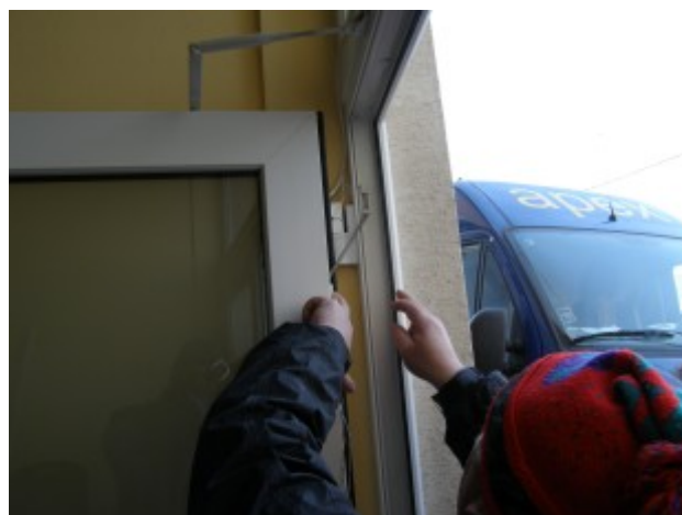
Inštalácia priechodky kabeláže
